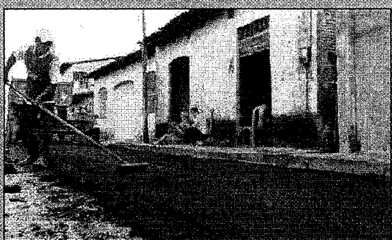
ASFALTO DE PRIMEIRA QUALIDADE CHEGANDO NAS RUAS DE SANTA HELENA
